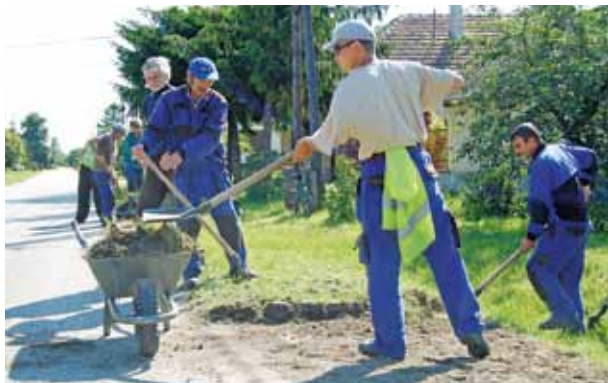
Belterületi közúthálózat javítása, útpadkázási munka Tómpán
