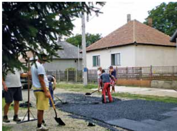
Belterületi közút aszfalt burkolattal való ellátása, Novajidrány
