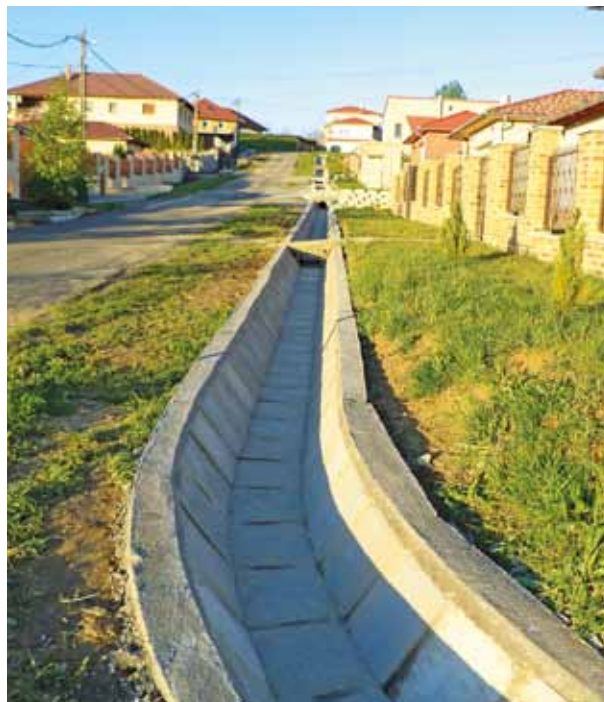
Komló, belterületi csapadékvíz-elvezetés
