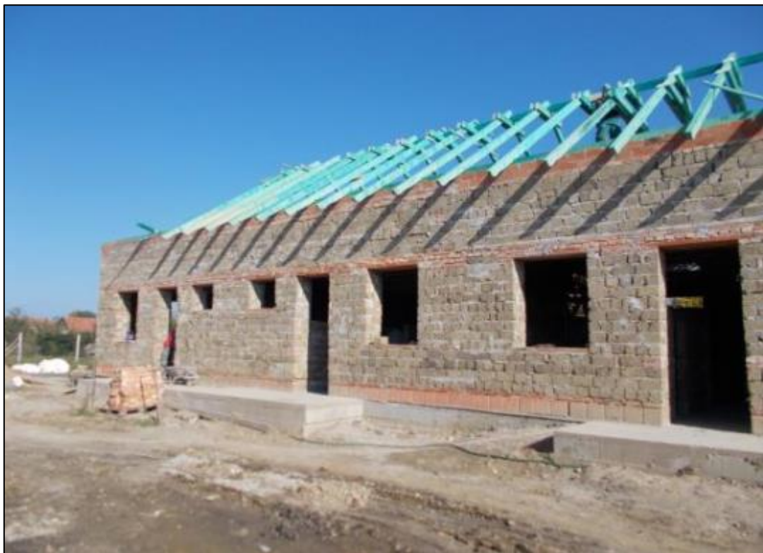
Következtetett a fedélszék megépítése.
