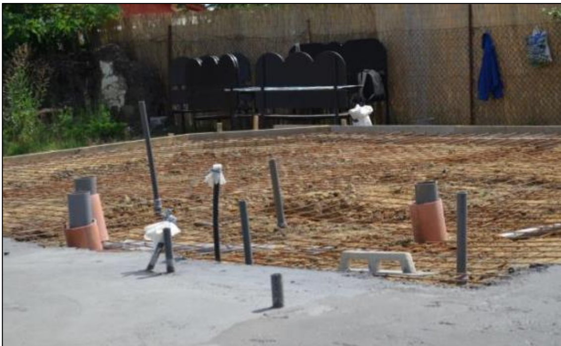
Kézi betonkeveréssel készül a vasalt aljzatbeton.
