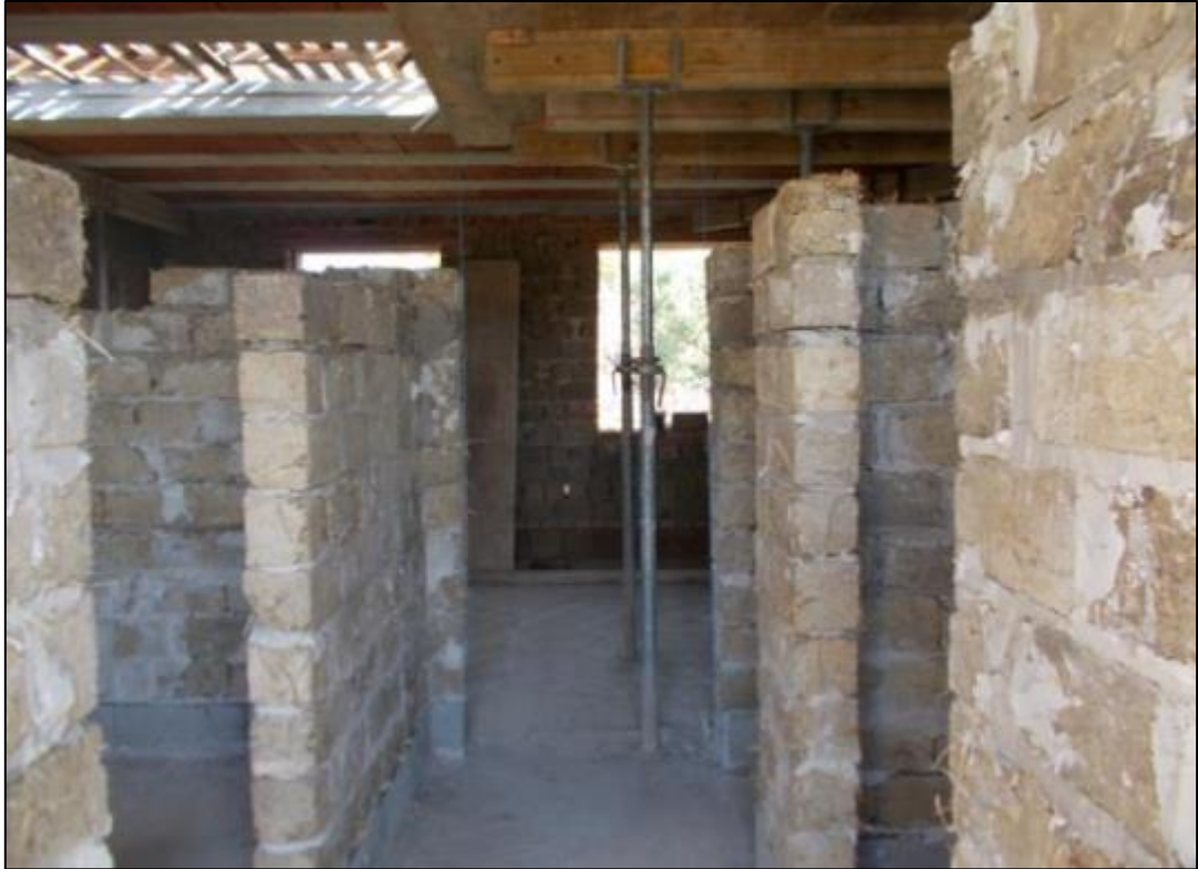
Közben a földszinten készültek a vályogtégla válaszfalak
