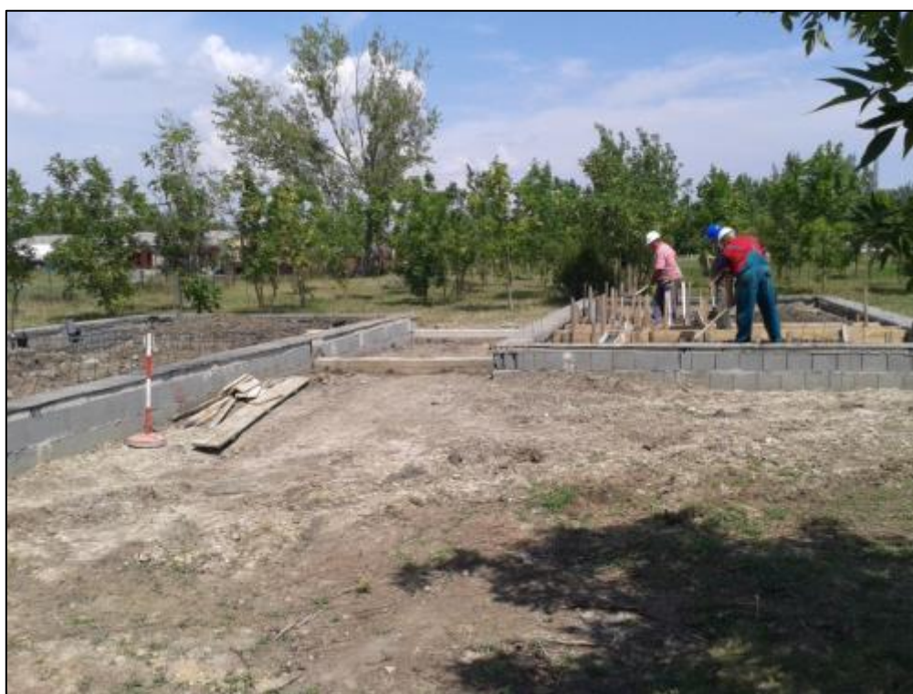
A bontással egyidőben az építés is megkezdődött. Földmunka, alapozás, lábazati Zsalukőfal-készítés.
