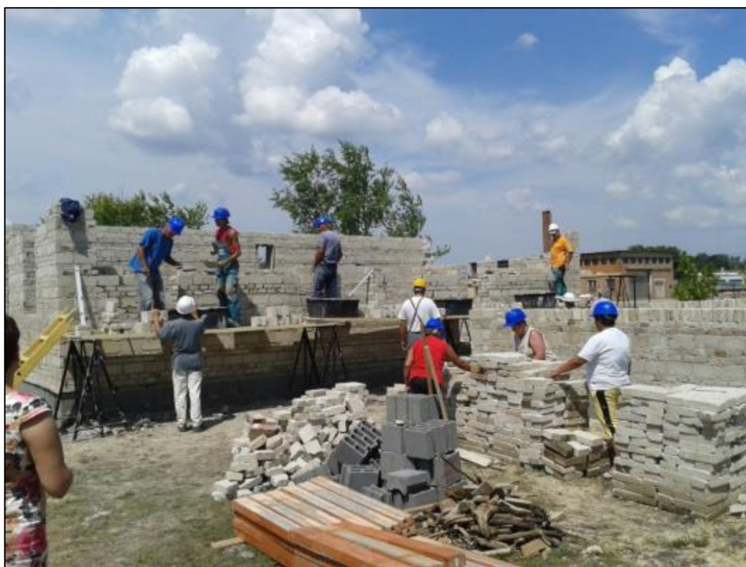
A második ház falazása is elkezdődött
