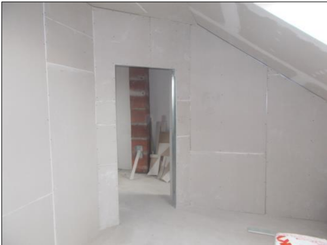
A tetőtérben gipszkarton válaszfalak készültek, hogy a födém minél kevesebb terhet kapjon
