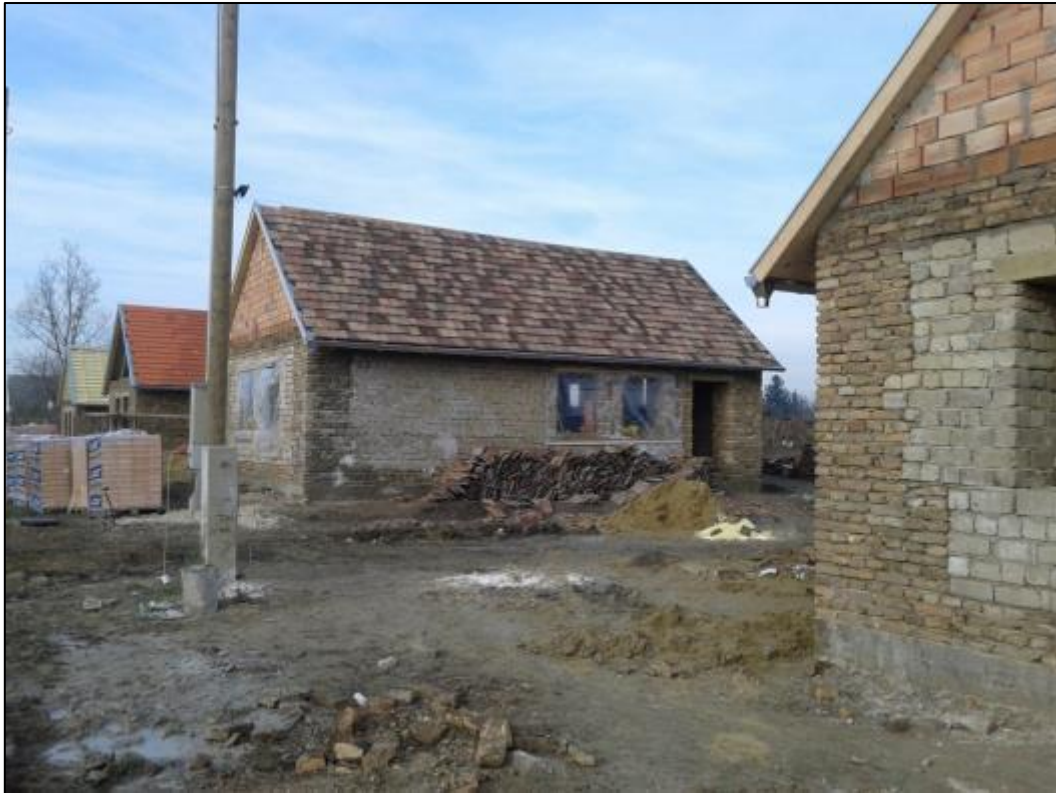
Nem jutott vályogtéglá az oromfalaknak, ezek égetett blokkteglából készültek 25 cm-es vastagságban.
