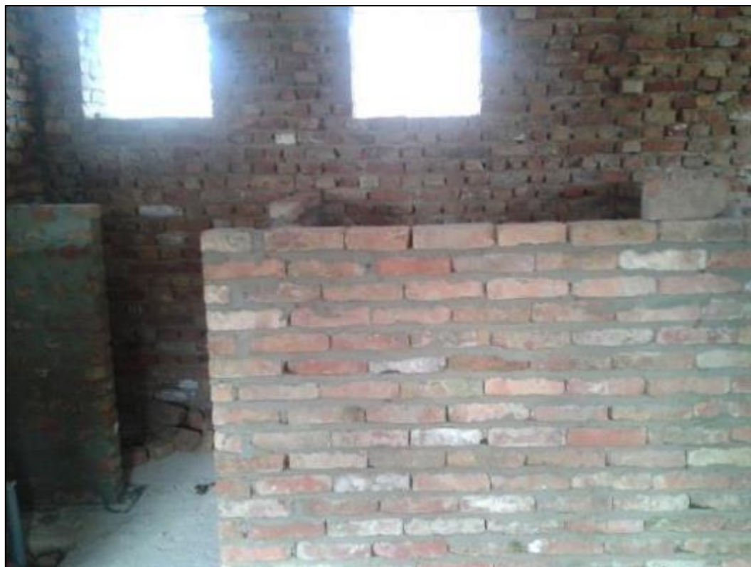
A válaszfalak is bontott téglából készültek
