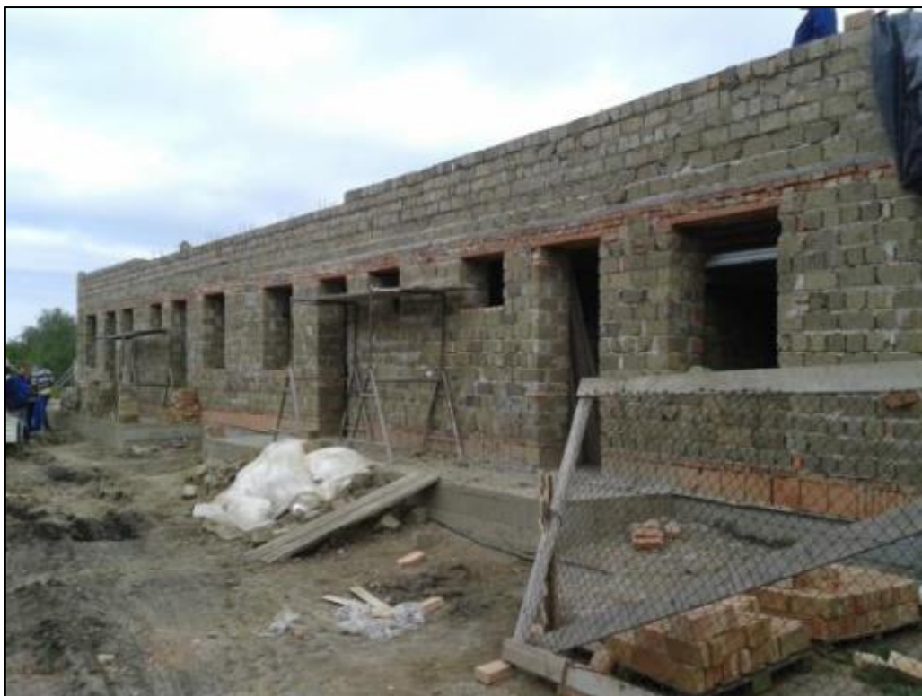
A tetőtéri térdfal is vályogtégglából készült.
