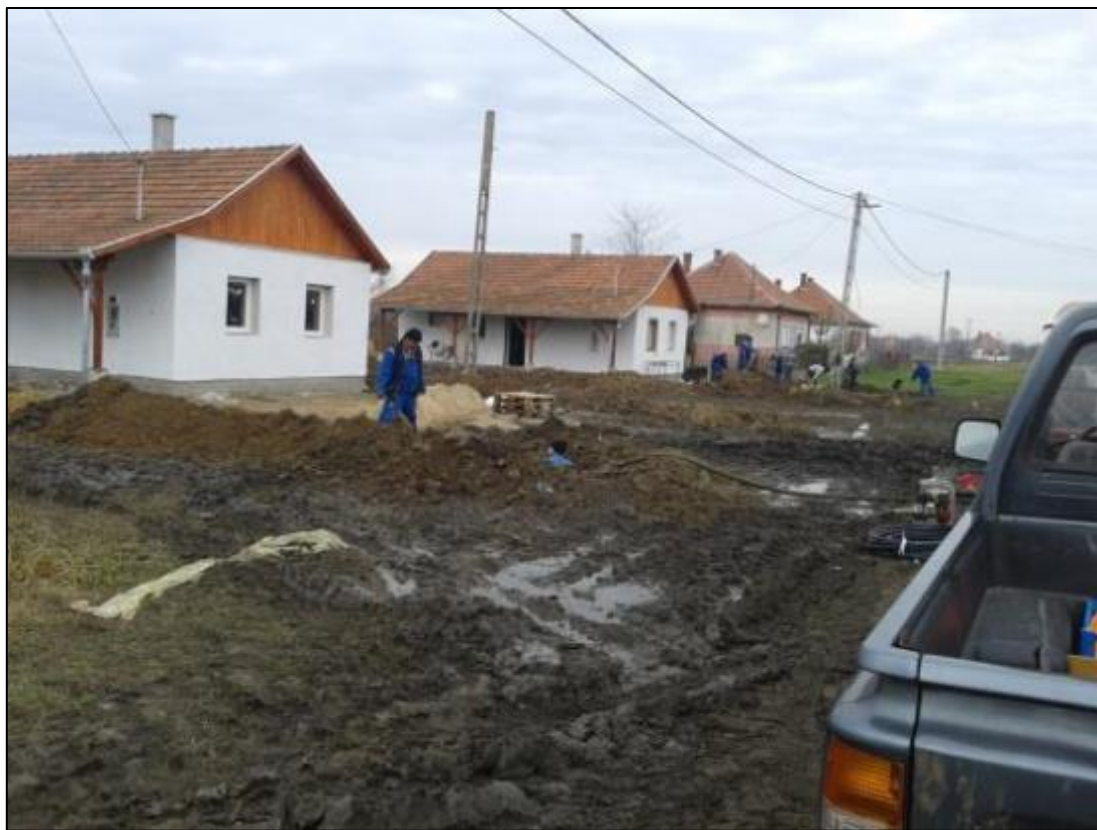
A rendkívül csapadékos időjárás nehezítette a kivitelezést, sok többletmunkával járt. Pl. a földbe kerülő vezetékek fektetésénél szivattyúzni kellett a földárokba a vizet
