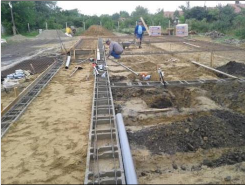
A feltöltésbe kerül a víz-és csatorna alapvezeték
