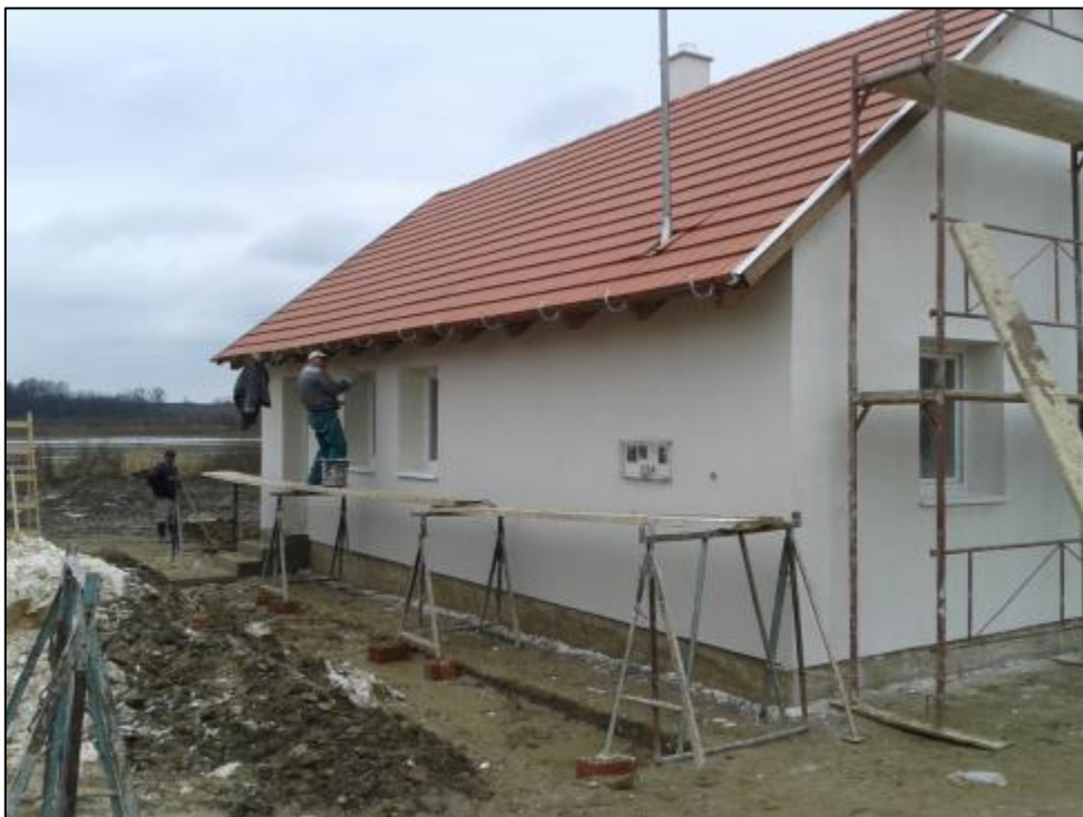
Utolsó simítások a homlokzatvakoláson
