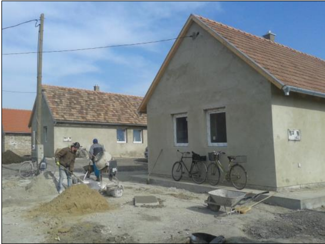
A belső munkákkal egyidejűleg készült a homlokzatvakolás 2015 tavaszán, amikor az időjárás már engedte.
