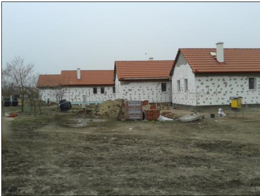
A hőszigetelést tartó dübelezés üvegszövet-hálózás előtti glettelése
