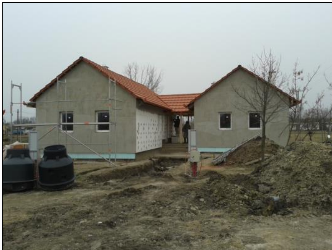
A homlokzati falakra hőszigetelés került, hogy a fűtési költség ne jelentsen nagy terhet a bérlőnek. Túl magas rezsi veszélyeztetné a bérleti díj rendszeres befizetését
