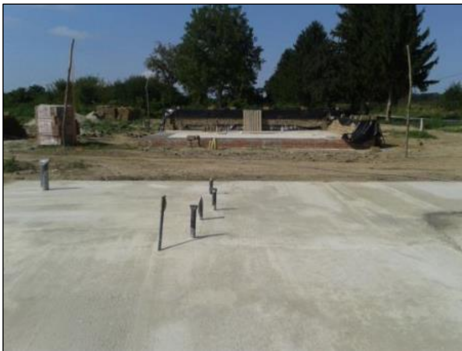
A padló alatti víz- és csatornavezetékek elhelyezése után történt a fogadósínt betonozása
