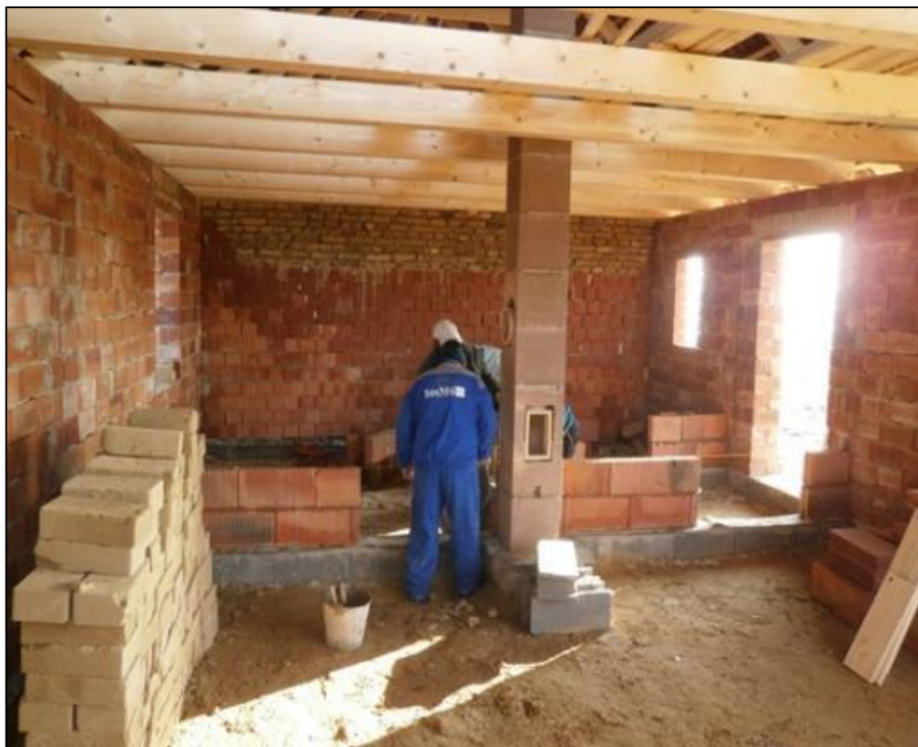
Tető alatt készülhettek a belső munkák, a válaszfalazás, kéményépítés, padlófeltöltés
