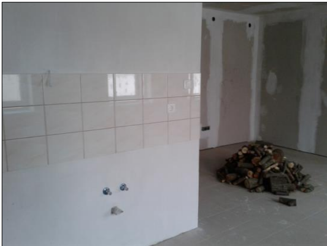
A falakra „szárazvakolat” készült, rögtön festhető, nem kellett várni a kiszáradásra.
