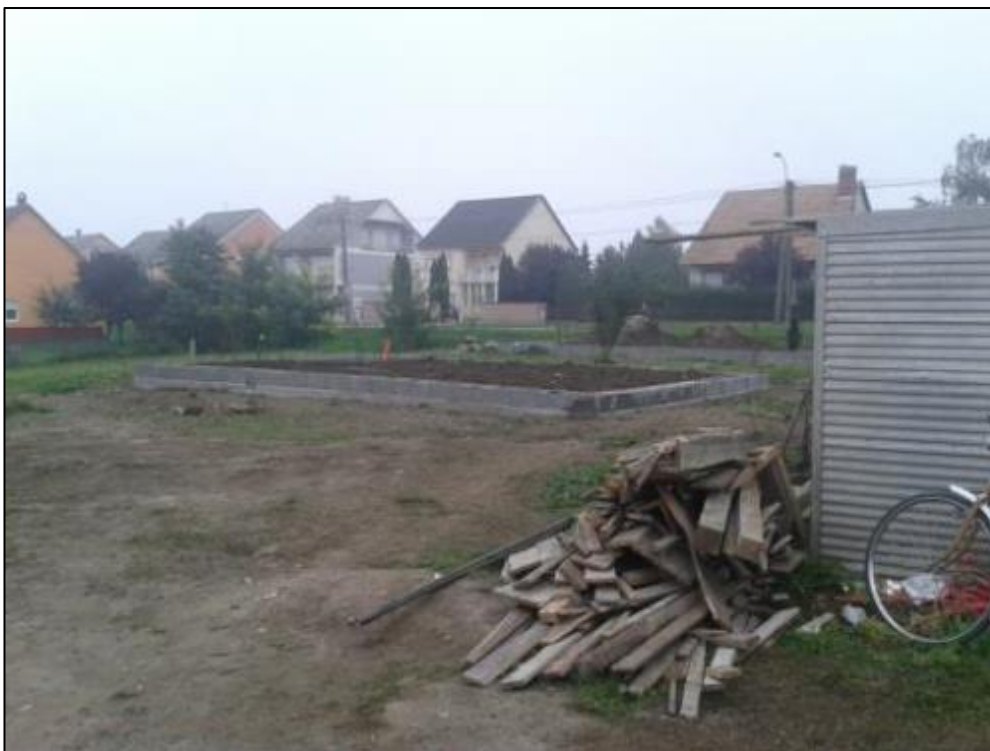
A gerendarácsra 1 sor zsalukő készült, így alakult ki a tervezett magasságú padlószint.
