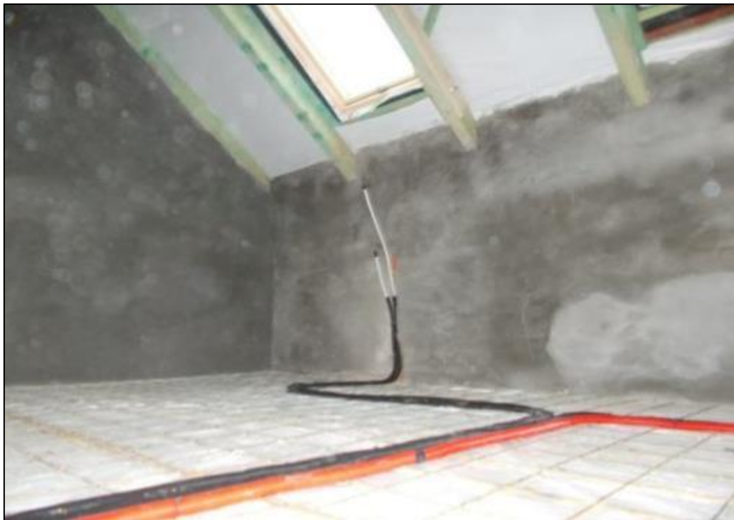
A tetőtérben a fűtésvezetékek a padlóban haladnak. Ezután készül az aljzatbeton
