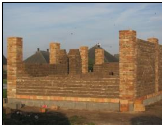
Erősítő pillérek falazása a programban foglalt épületbontásokból származó téglából. A falazat egy sor égetett blokktéglával indul, hogy a vályog felázását megelőzzük.
