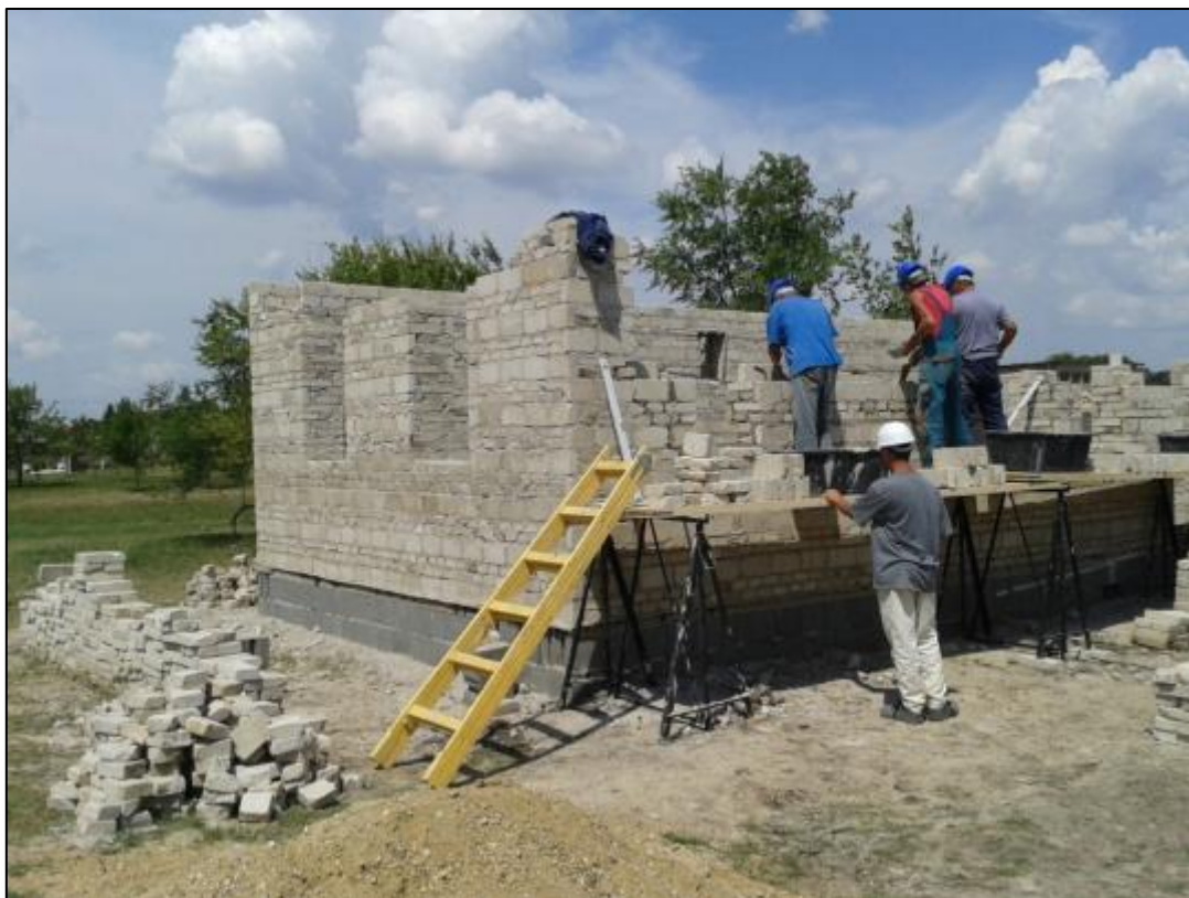
Az első ház falazása bontott nagyméretű mészhomoktégglából, 38 cm vastagságban
