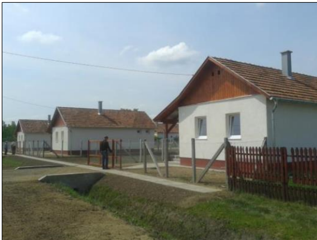
Utcakép a tereprendezés, járdaépítés után
