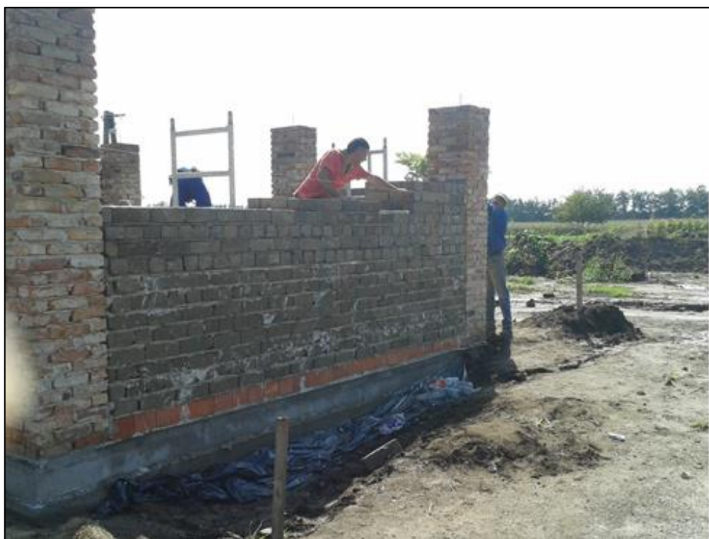
A falazat egy sor égetett blokktéglával indul, hogy a vályog felázását megelőzzük. A fal vastagsága 60 cm
