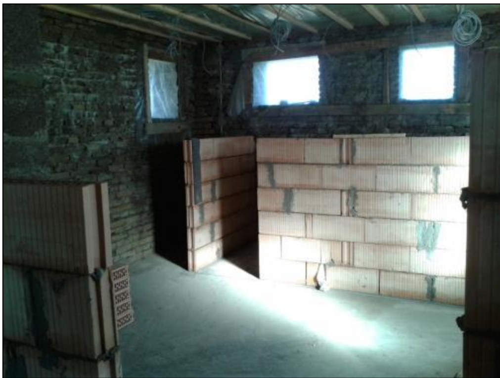
Az eső elől már be lehetett menekülni a házba, a tetőfólia védelmében elkezdődött a válaszfalazás
