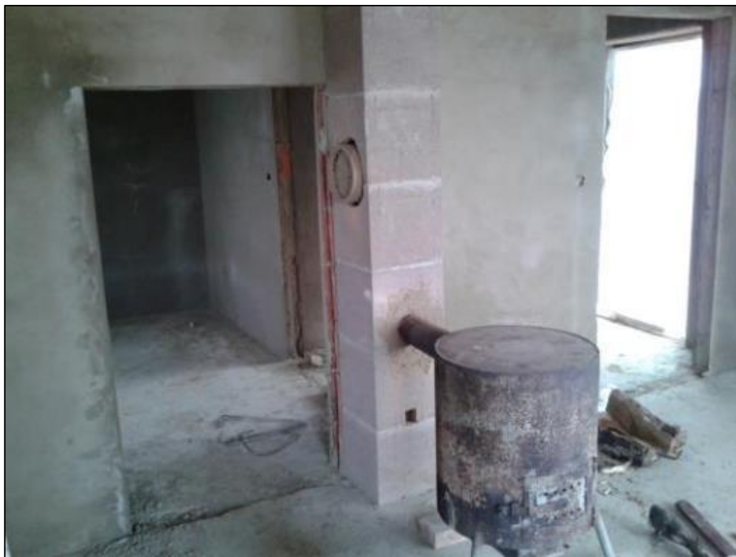
A tél folyamán dobkályhával oldották meg az ideiglenes fűtést, készülhetett a gépészeti alapszerelés, majd a belső vakolás
