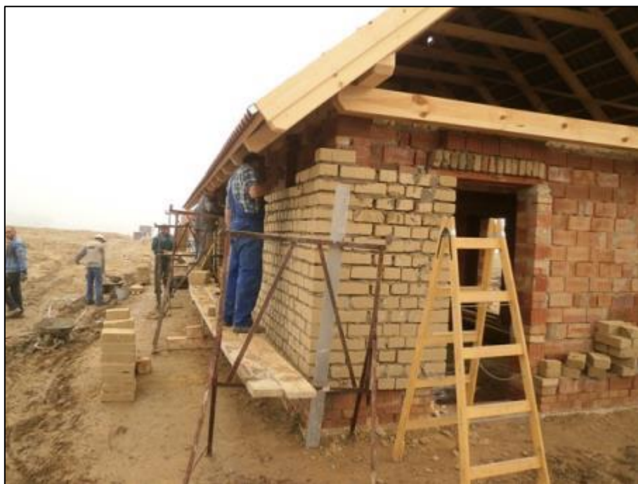
Cél volt mielőbb tető alá hozni a házakat, ezért előbb téglavázszerkezet készült, ami hordja a tetőt, utólag készült a vályog kitöltőfalazat
