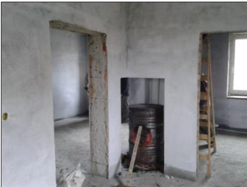
A téli munkavégzést tette lehetővé a fatüzelésű dobkályha, egyben a falak száradását is elősegítette.
