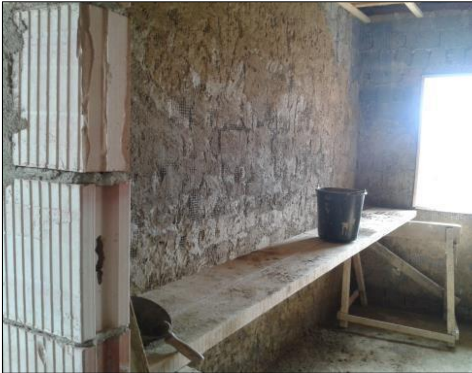
A belső vakolás előtt a vályogfalakra vakolattartó műanyag hálót kell rögzíteni.
