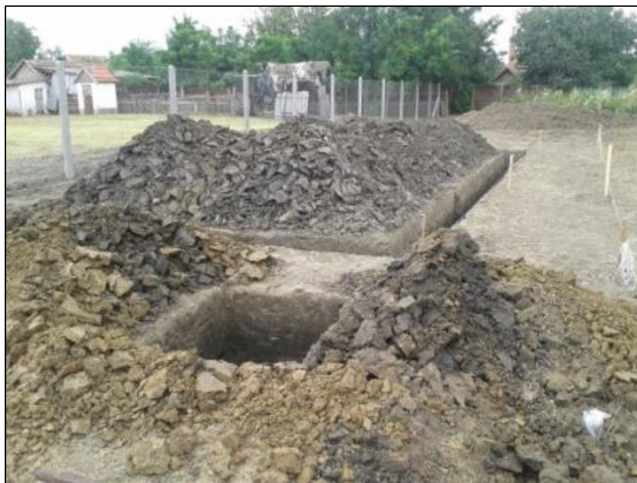
Az alapárok-kiemelés kézi munkával készült
