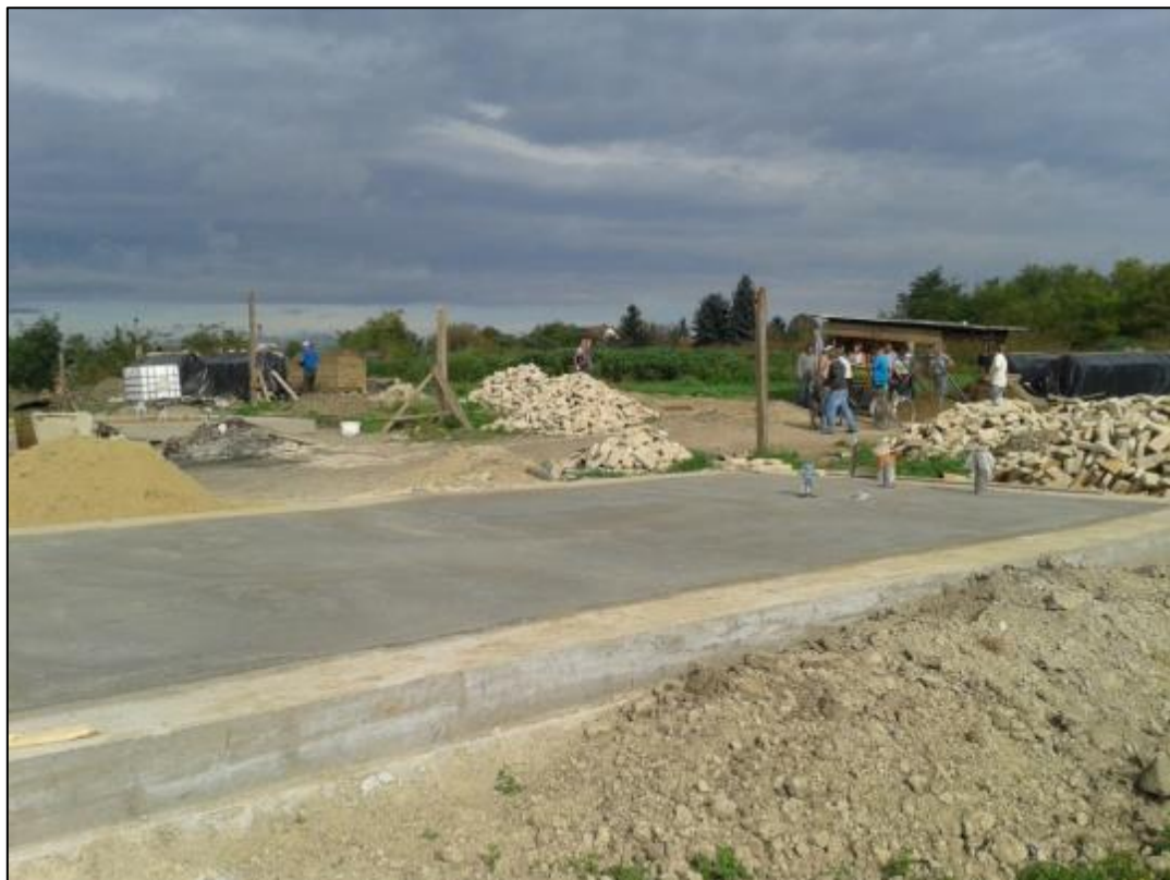
A bebetonozott fogadószint. Előzetesen elhelyezték a padló alatti csővezetékeket
