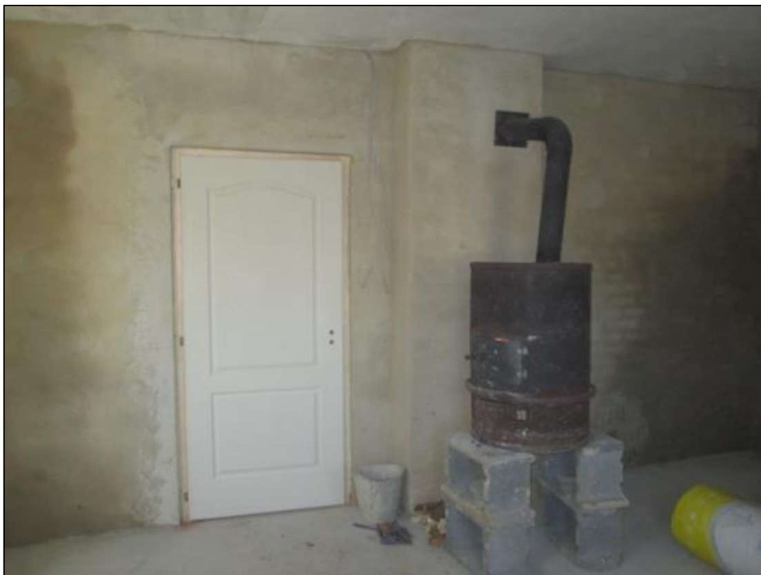
Dobkályhával fűtöttek, hogy télen is lehessen dolgozni, egyben elősegítették a falak száradását
