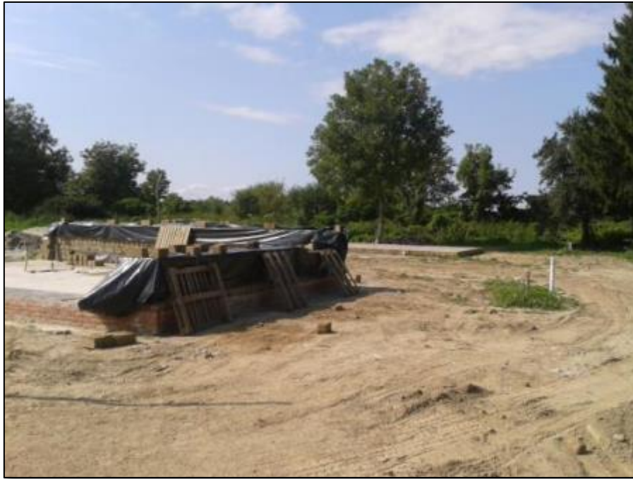
Késlekedés nélkül indul a falazás. Minden nap védeni kellett a falazatot is a bármikor eleredő esőtől
