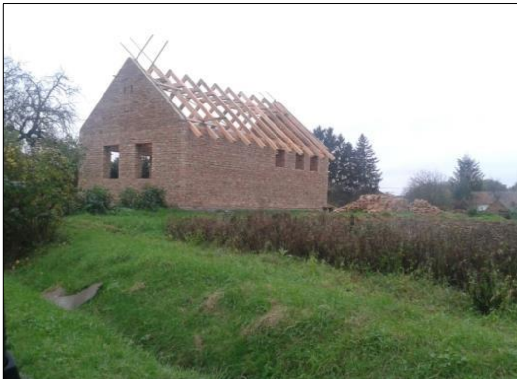
Ekkor még csak a szaruzat készült el az ácsmunkából
