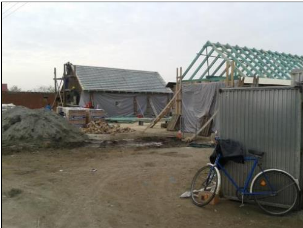
A fedélszékek felépítve, fóliázás, lécezés
