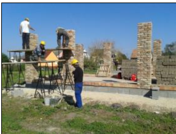
Erősítő pillérek falazása a programban foglalt épületbontásokból származó téglából. A falazat egy sor égetett blokktéglával indul, hogy a vályog felázását megelőzzük.
