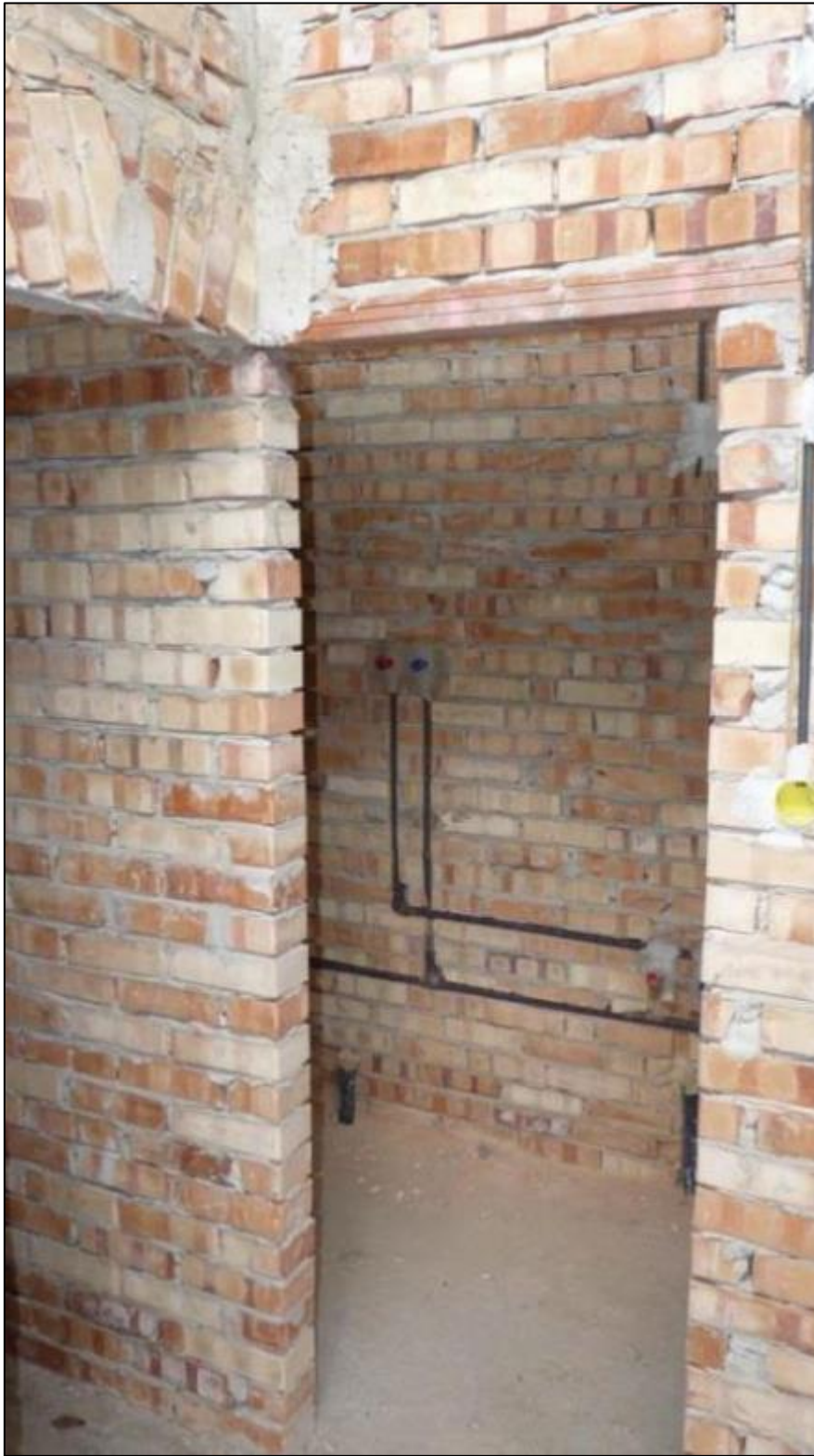
A válaszfalazás után következett a villany, víz, és csatorna alapszerelés
