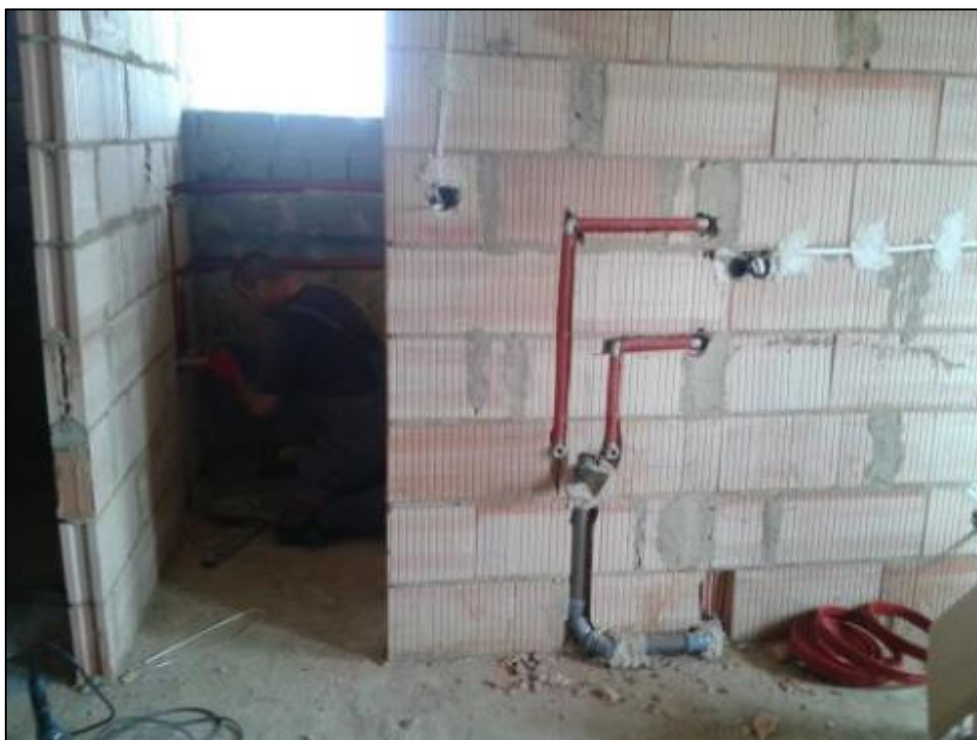
A tetőfedés elkészültét a válaszfalazás, azután a gépészeti alapszerelés követte
