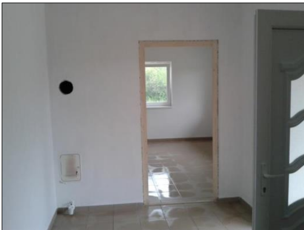
Elkészült a meszelés, a padlóburkolás
