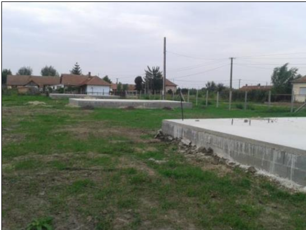
Kész fogadósíntek a földbe kerülő vezetékek elhelyezésével
