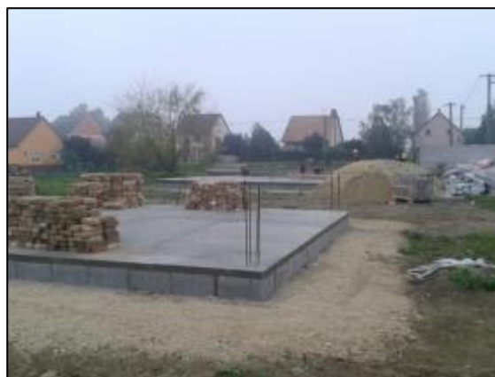
A fogadószint bebetonozva
