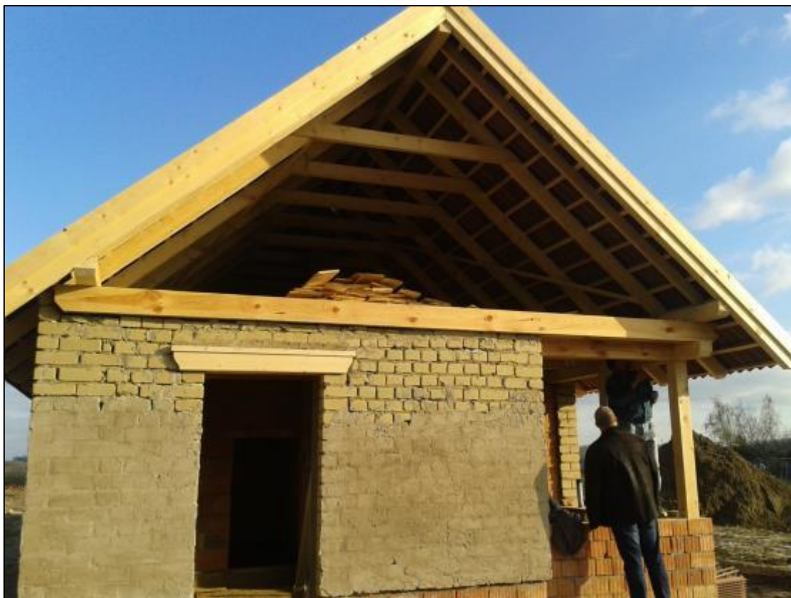
Falazás és az igényesen elkészített fedélszék
