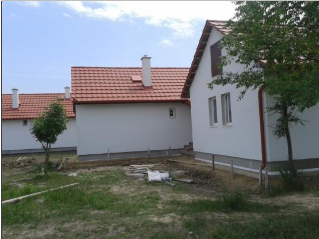
A kert felől is folyik még a járdaépítés, majd a tereprendezés
