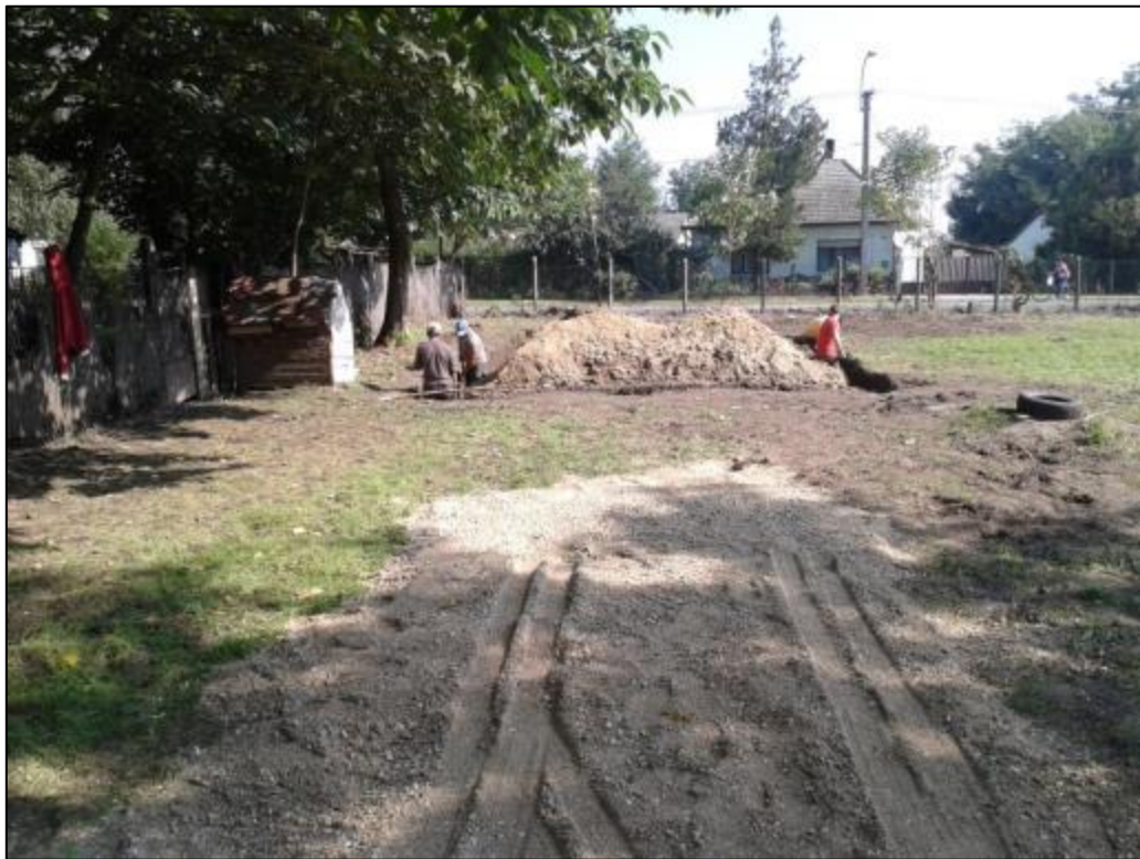
Alapárok földkiemelése kézi munkával. Az egyedül álló háznál hagyományos sávalap készült.
