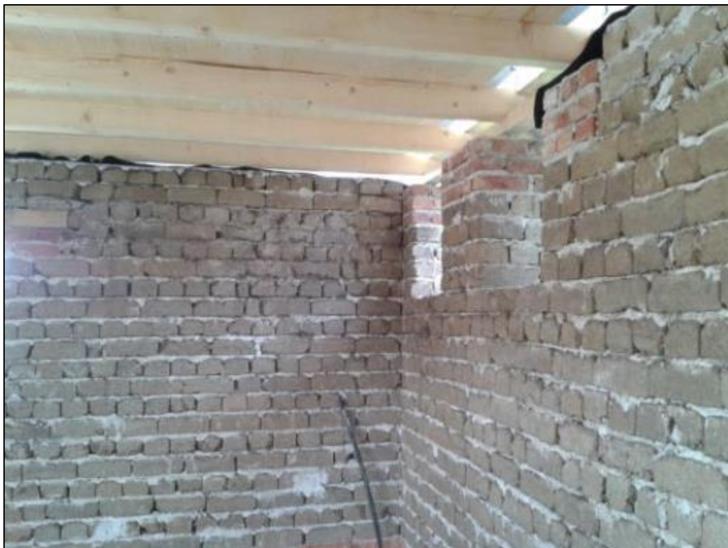
Alulról látszó gerendákkal ún. pórfödém készült
