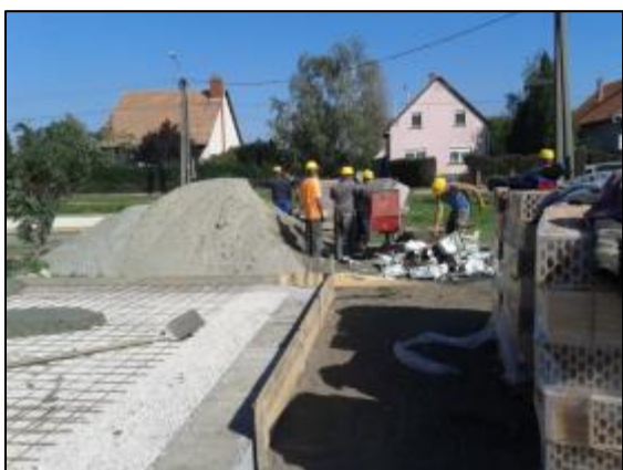
A fogadószint betonozása helyszíni keveréssel
