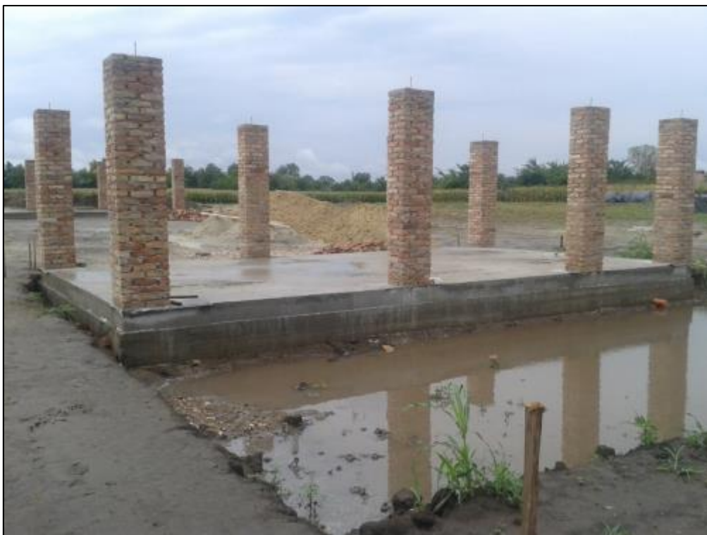
Erősítő pillérek falazása a programban foglalt épületbontásokból származó téglából. Sajnos, a kivitelezés idején igen sokszor, és nagy mennyiségben esett az eső. Ez a munkát nagyon nehezítette, hátráltatta.
