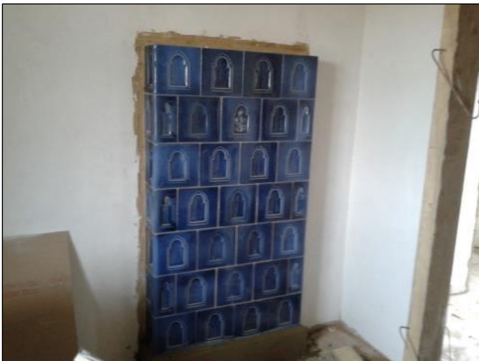
Két szobát fűt a helyi mester által – a költségkereten belül – készített cserépkályha
