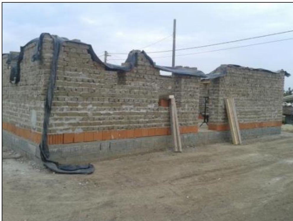
A falazat egy sor égetett blokktéglával indul, hogy a vályog építés közbeni felázását megelőzzük. A fal vastagsága 45 cm
