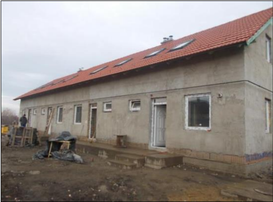
A tetőtéri ablakok a cserpezéssel együtt készültek el
