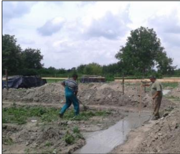
Alaptest betonozása
