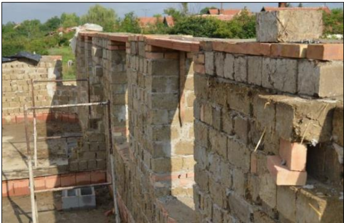
A nyílásáthidakók előregyártott vázkerámiából készültek.
