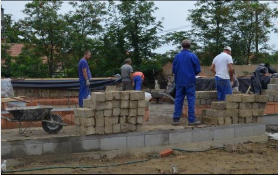
Kezdődik a falazás, az alsó sor égetett téglából, hogy megelőzzük az eső miatt felázásproblémáját
