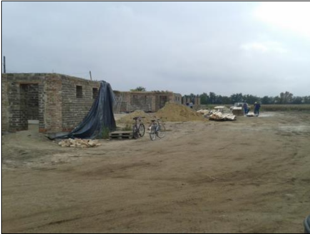
Minden munkanap befejeztével le kellett takarni a falakat, kezdéskor pedig kitakarni, hogy száradni tudjon.
