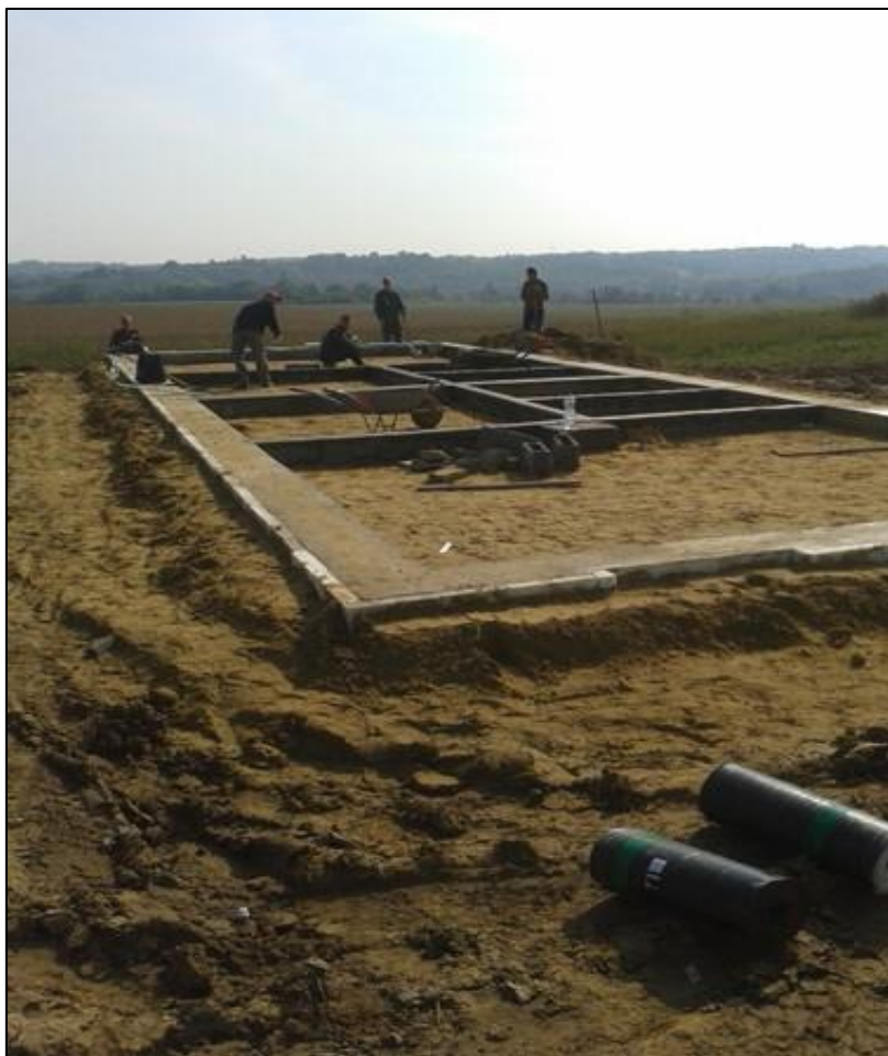
Alap és zsalukő lábazat bebetonozva
