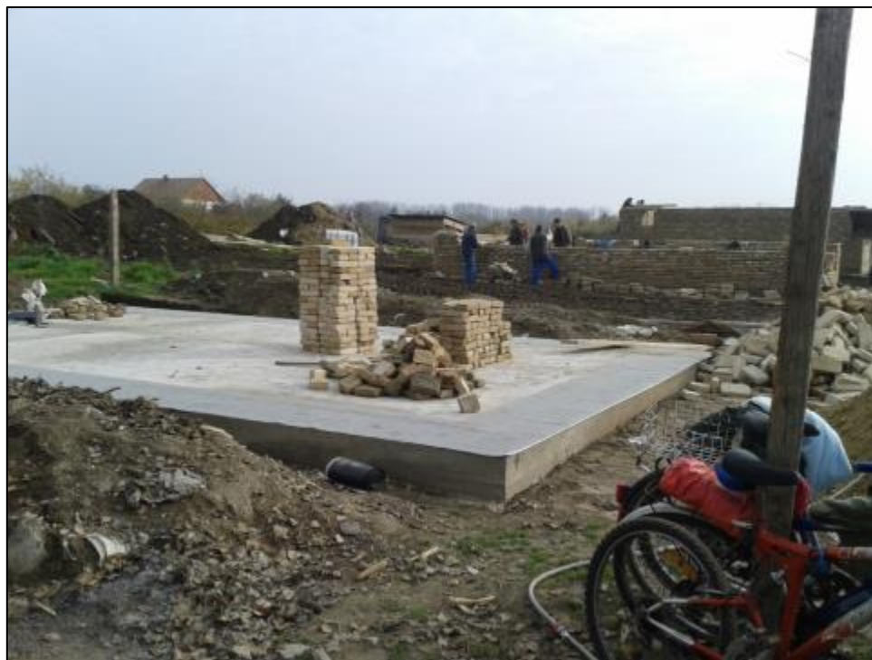
A házak egymás után, ütemezve készültek. Az elsők az ácsok dolgoznak, a másodikon a főfalak építése folyik, a harmadiknál a vízszigetelés készül.
