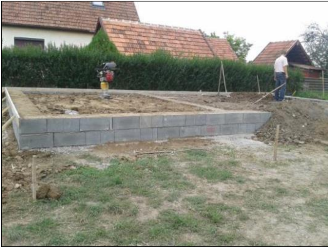
Két sor zsalukő emelte a tervezett szintre a padlósíkot. A földfeltöltést döngölőbékával lehet hatékonyan tömöríteni.
