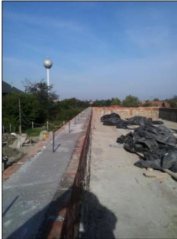
A tetőtéri vasbeton koszorú a bebetonozott talpszelemen-csavarokkal
