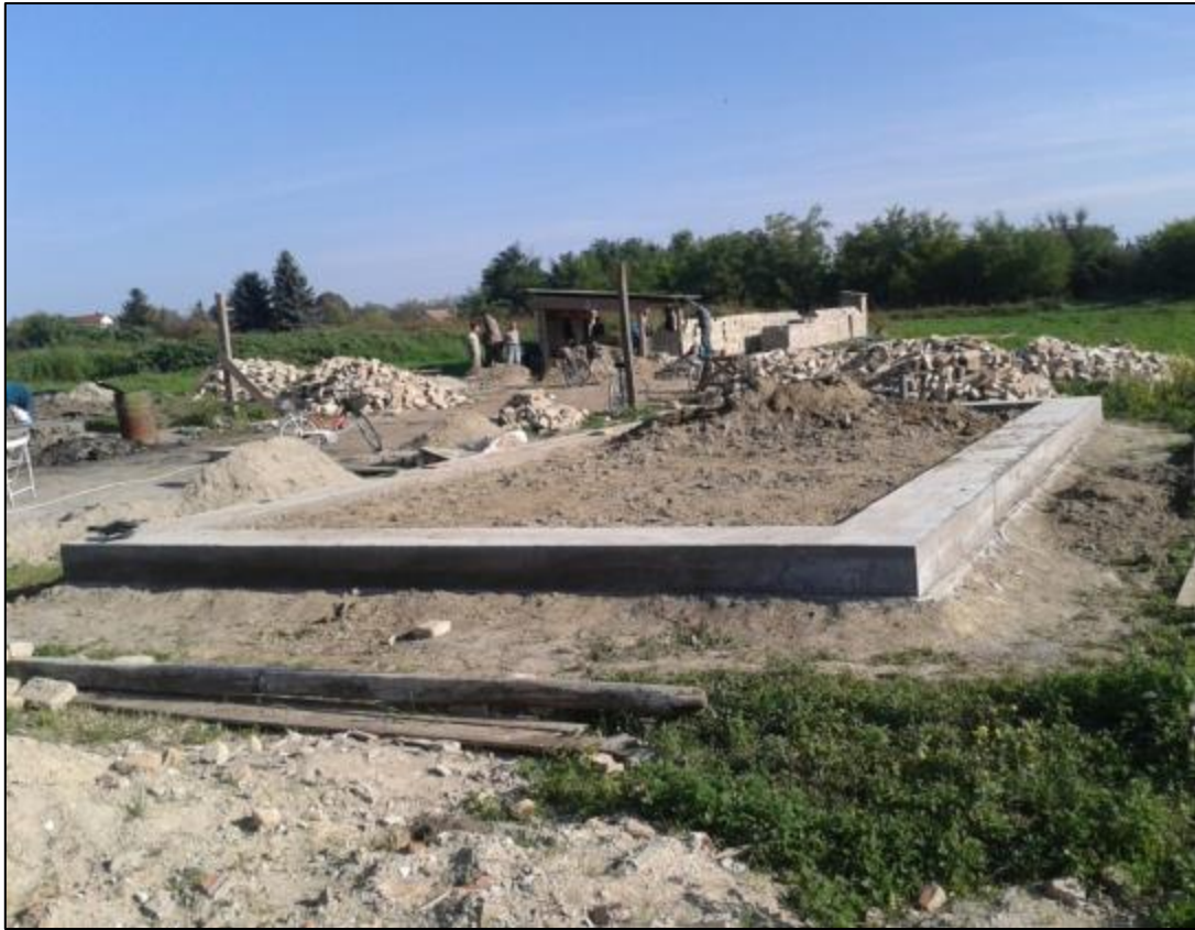
Az alaptest bebetonozva, kizsaluzva.
