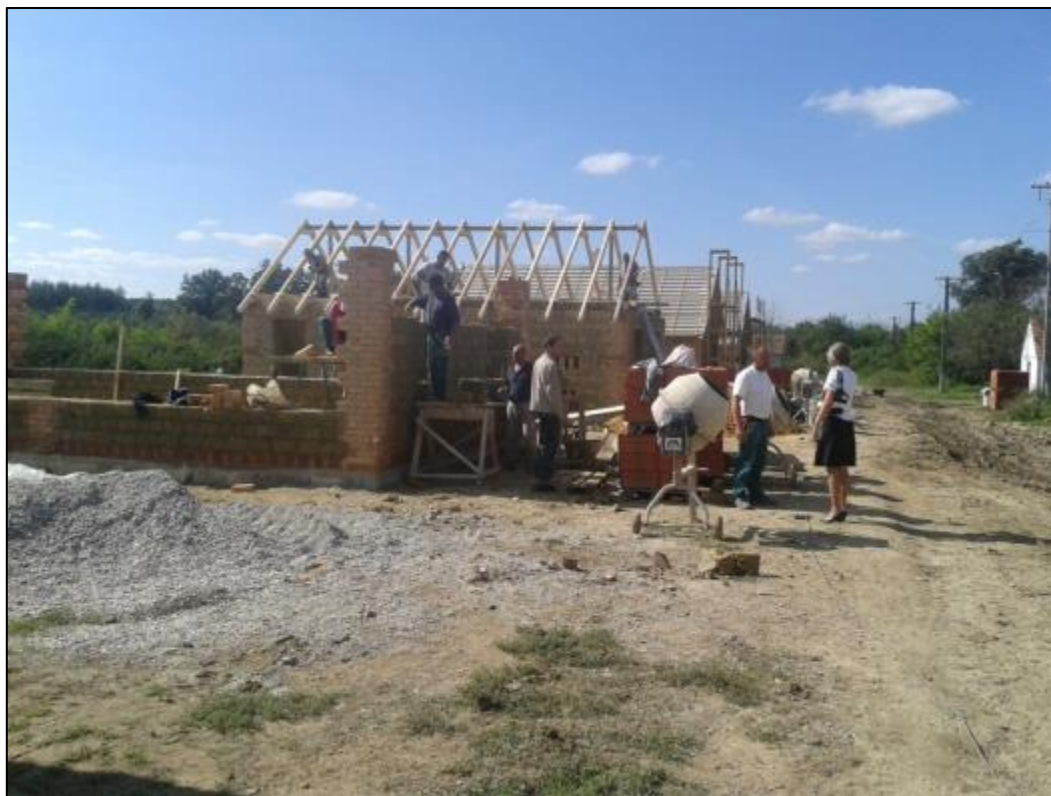
A kedvezőtlen időjárás ellenére ütemterv szerint haladt a munka. Elöl még falaznak, a mögötte álló házon készül a fedélszék, hátul készen vannak az oromfalak, a fóliázás, lécezés.
