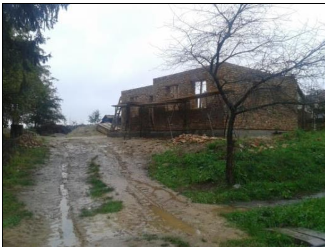
A rendkívül sok eső hátráltatta a kivitelezést. Egyrészt vizes téglával nem lehet dolgozni, mert szétesúszik a fal, másrészt a lassú kiszáradás hátráltatta a befejező munkákat.
