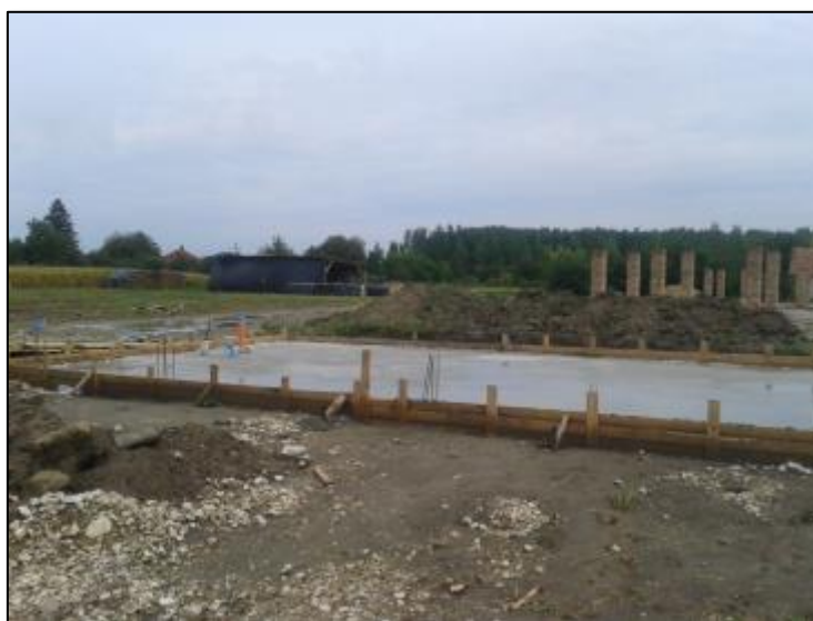
A bebetonozott fogadószint
