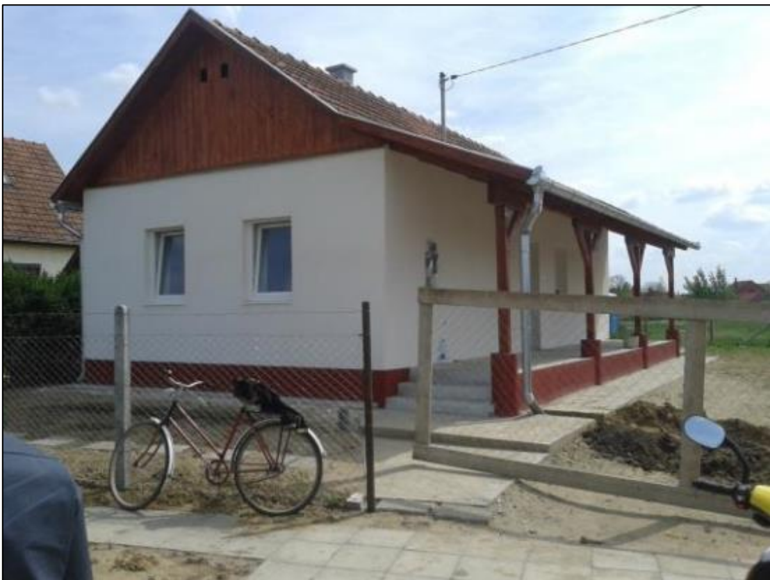
Az oromfalak deszkázva készültek.
