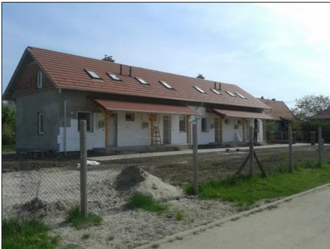
A homlokzati fal a hőtechnikai követelményeket kielégítendő, 10 cm vastag, hőszigetelést kapott
