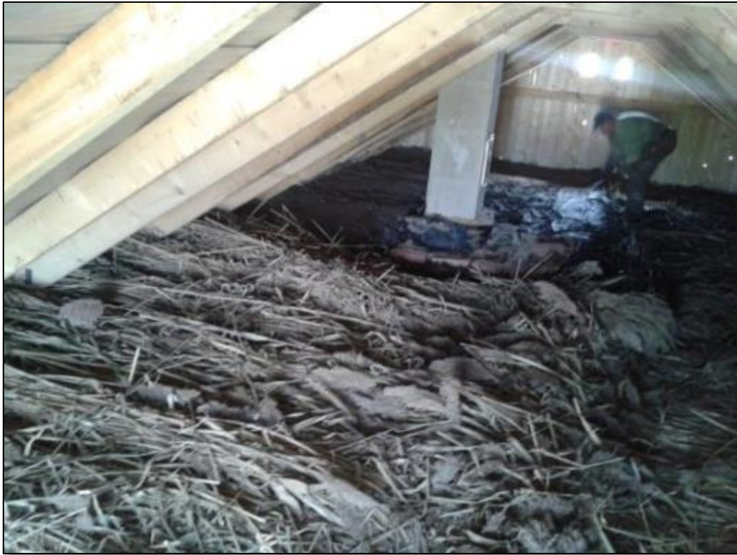
A padlásfödém hőszigetelését a helyben vágott nádból oldották meg. Ezt kell sarazni, azaz vályogból készül a padlásburkolat is.
