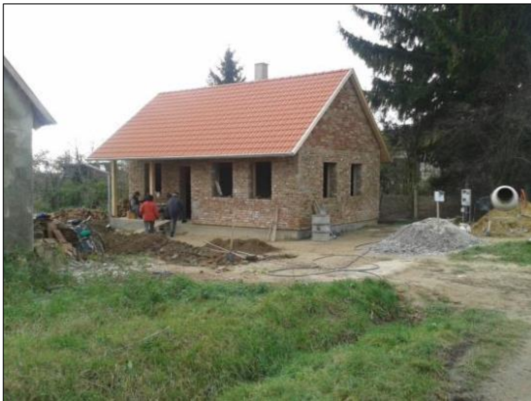
A következő munkafázis az ereszsatorna és a cserépfedés elkészítése
