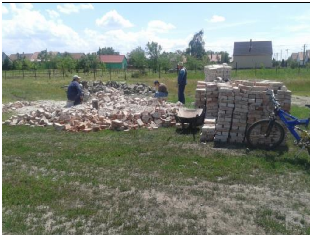
Hortobágyon nincs házépítésre alkalmas agyag, volt viszont lebontható ház: A program bontással, téglatisztítással kezdődött.
