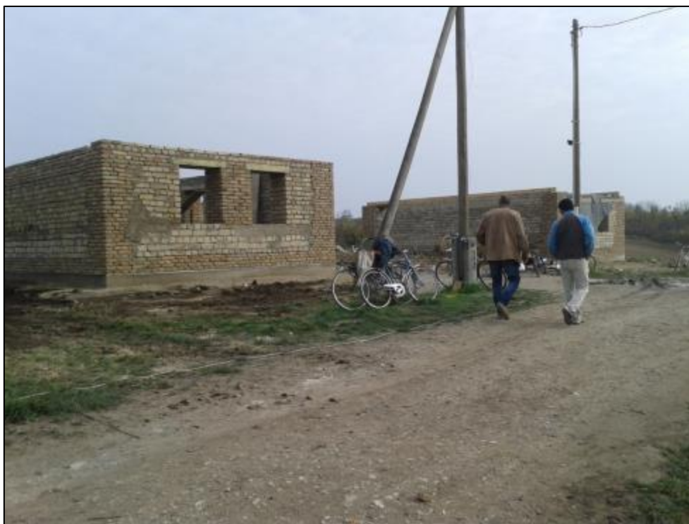
A volt iskolaépület lebontásából bontott téglák bőségesen rendelkezésre állt. A kezdősorok, a sarokpillérek, az ablakok közötti pillér is ebből készült, a kitöltőfalak vályogtéglaiból, 60 cm vastagságban.
