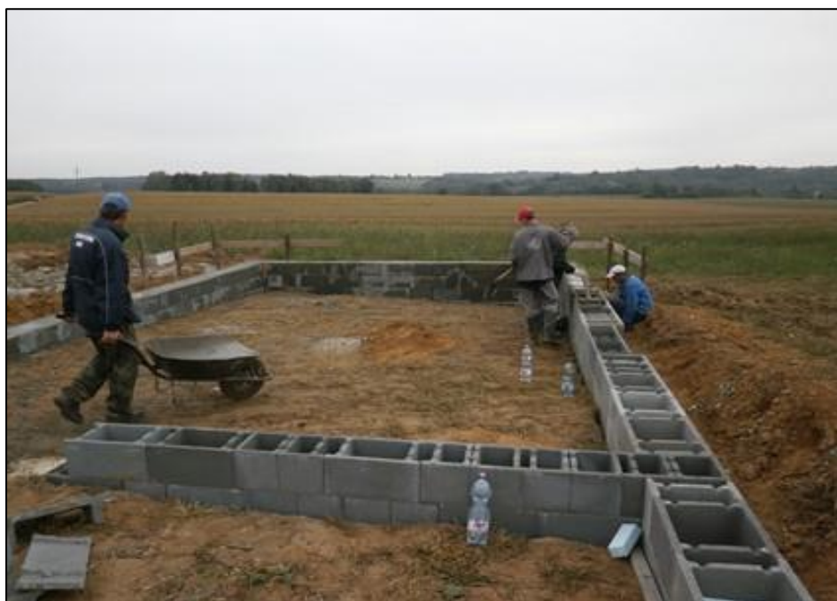
A lábazati zsalukőfal készítése
