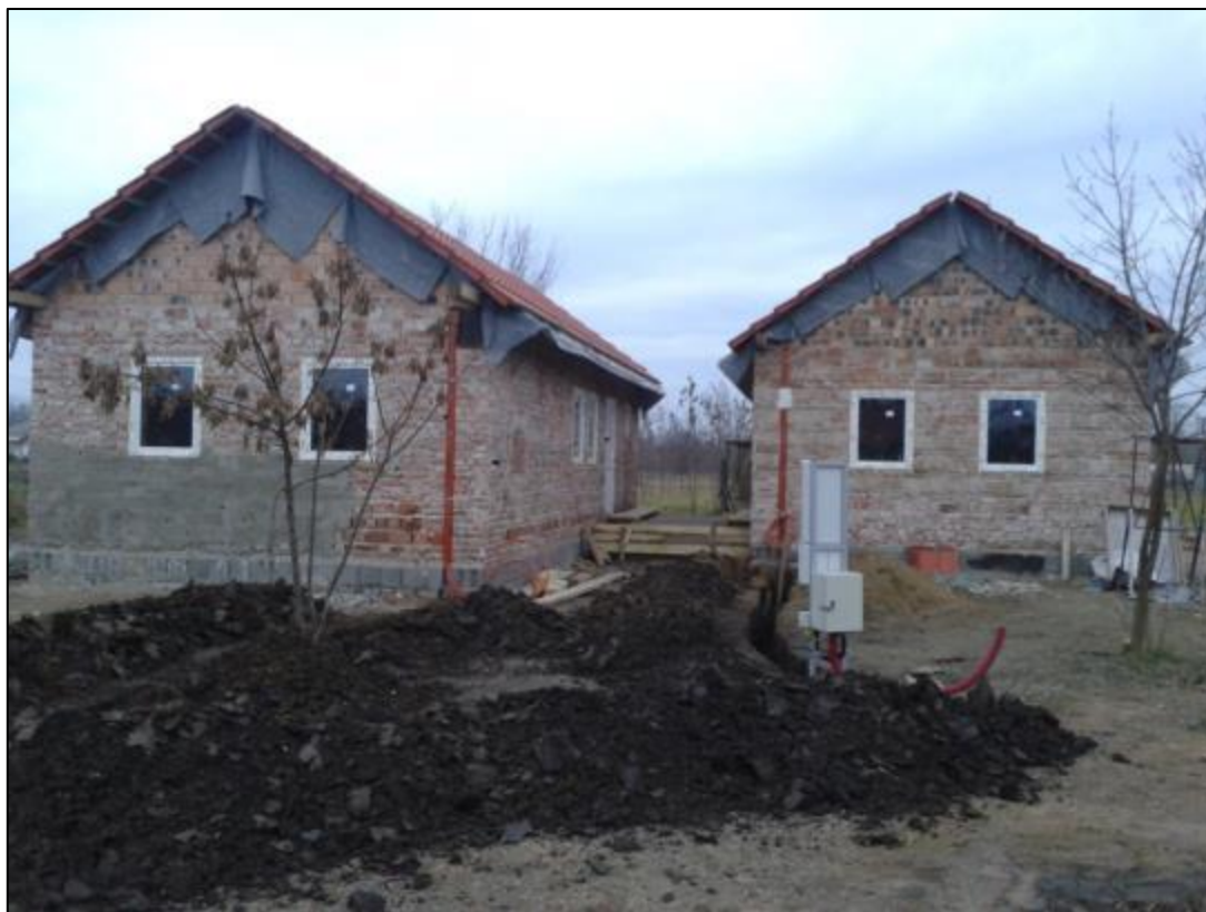
Földmunka a víz-és csatornabekötés számára
