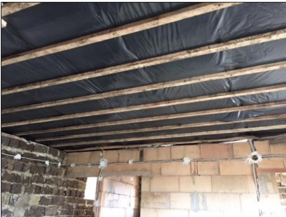
A gipszkarton mennyezet részére lécváz készült
