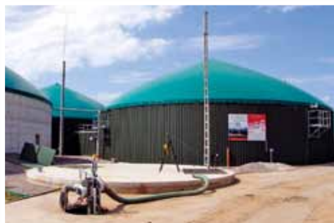
Fermentorok a biogáz üzemben
